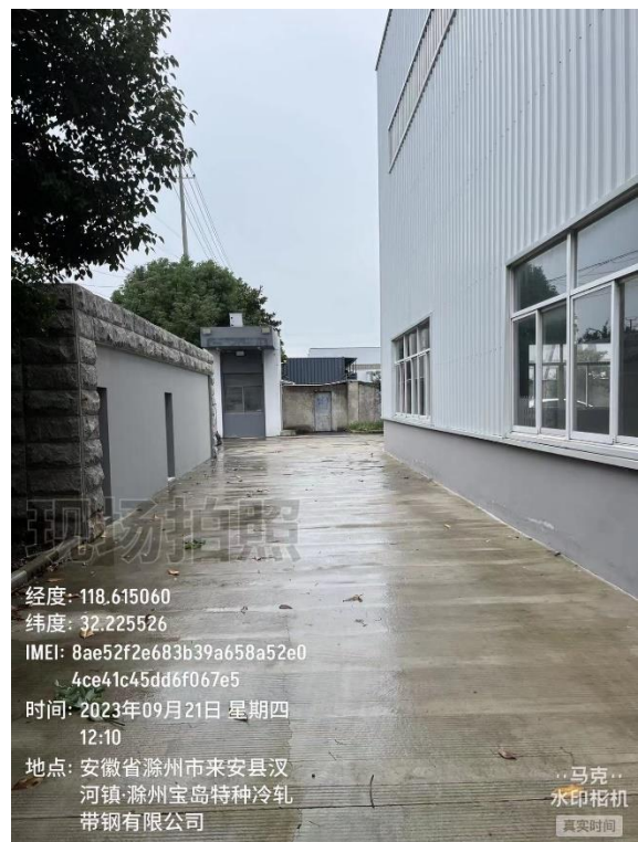
厂房北侧现场照片
