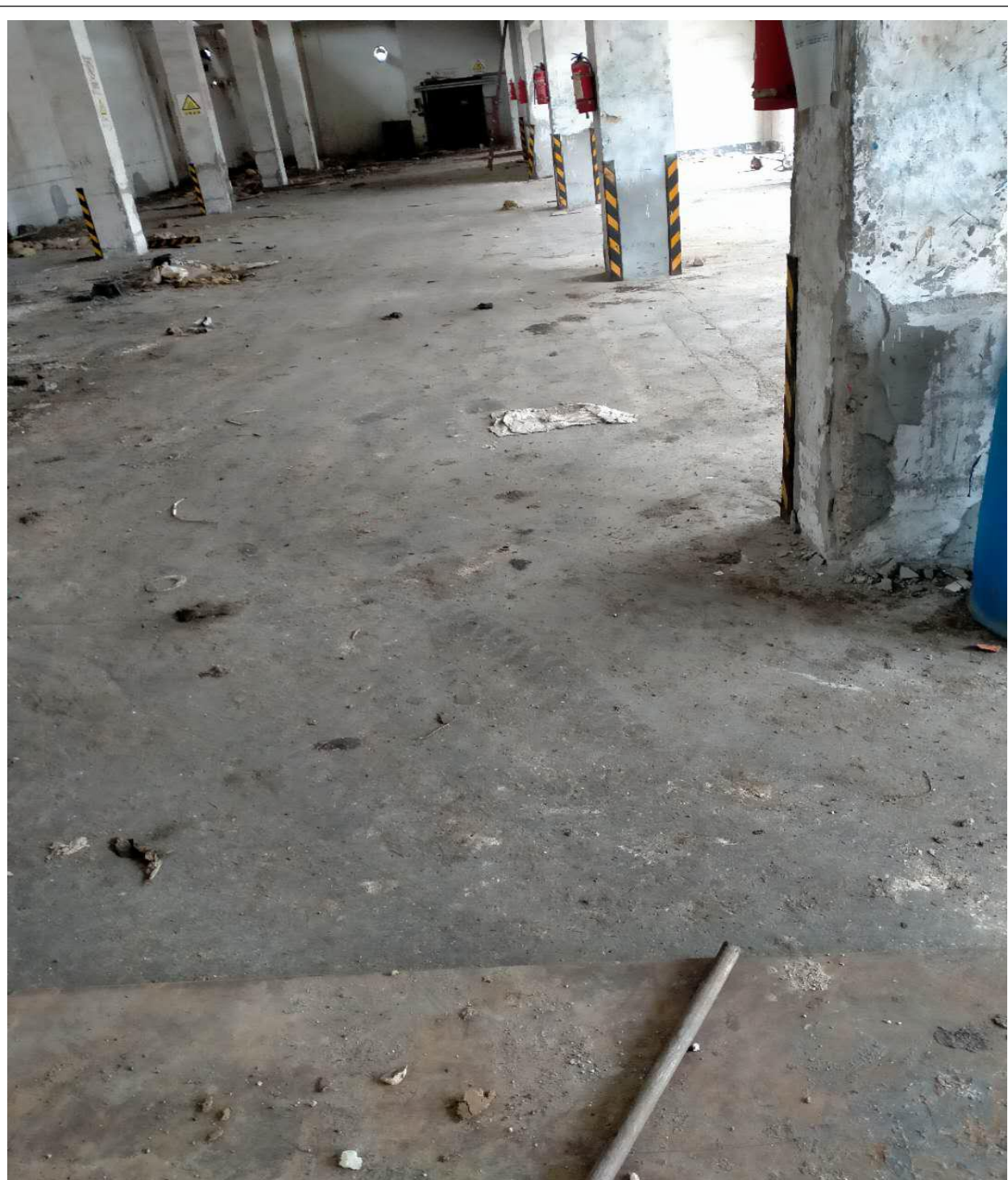
原生产车间地面现状
