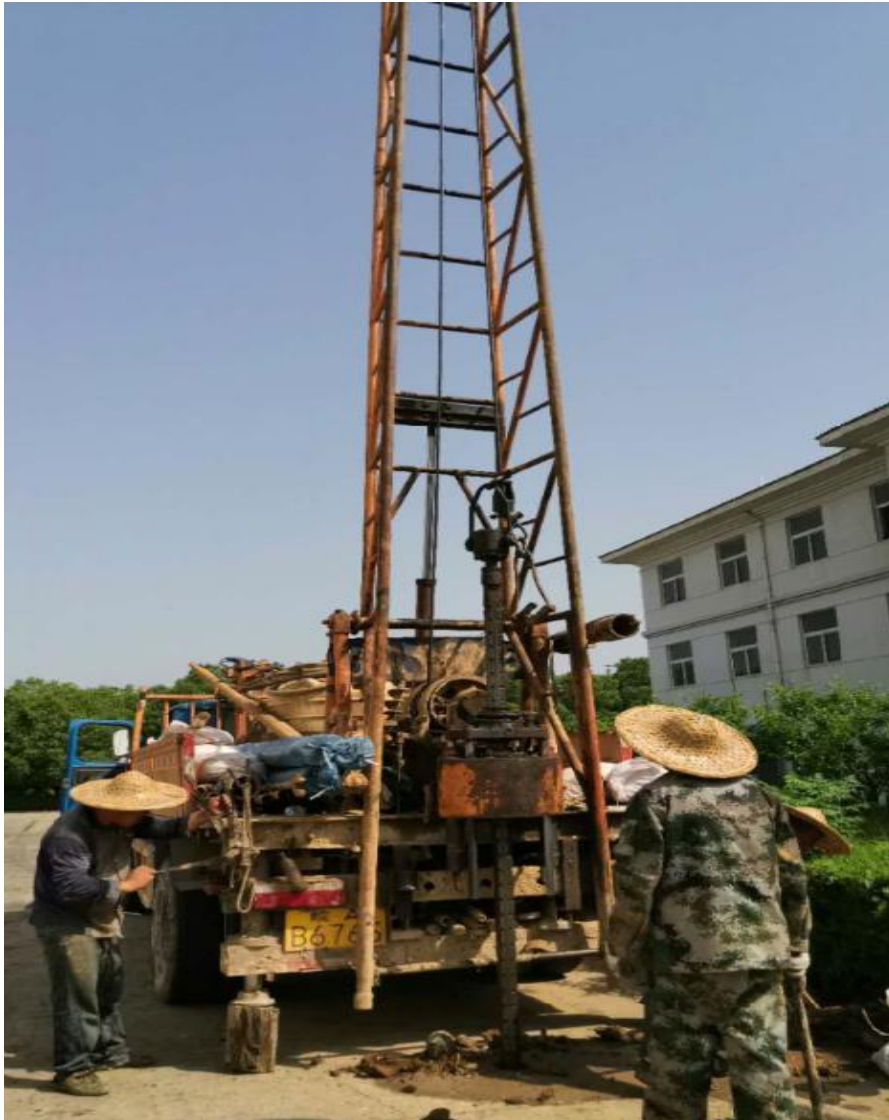
图 4.2-1 现场钻探设备照片
