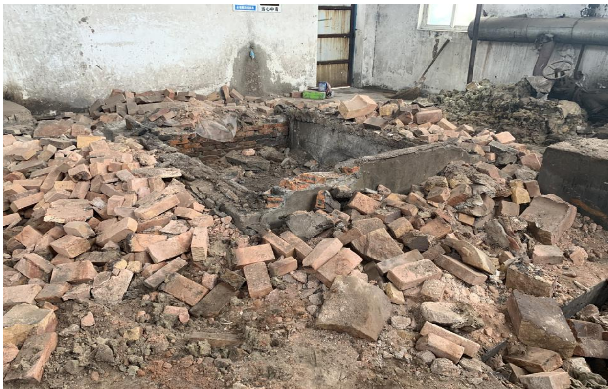
锅炉房内原燃煤锅炉拆除现状
